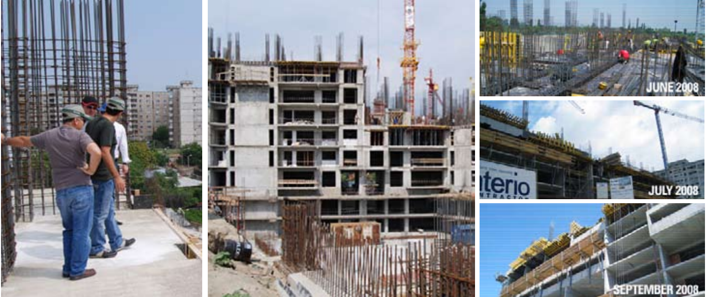
Bilder fra byggeplassene, Vitan Platinum Tower og Blue Tower.
